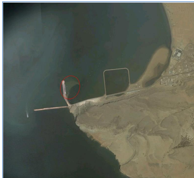
شکل ۴- تجمع رسوب داخل موج شکن بندر پزم
